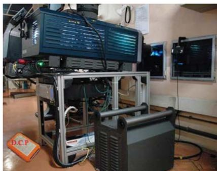
Le **Digital Cinéma Package** est un empaquetage de données (images, sons, sous-titres etc.) sur disque dur qui alimente les projecteurs numériques. Le D.C.P remplace les énormes bobines de film dont l'usage est en voie d'obsolescence. Le conditionnement du signal numérique destiné au D.C.P est complexe.
